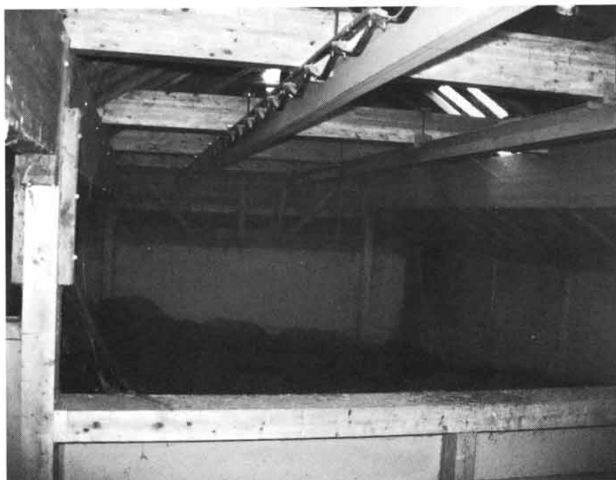
Fig. 9. L'entrait moisé sur lequel la grue est montée repose des deux côtés sur une poutre longitudinale en bois lamellé collé. Celle-ci s'étend par-dessus le tas de foin (12 m).
