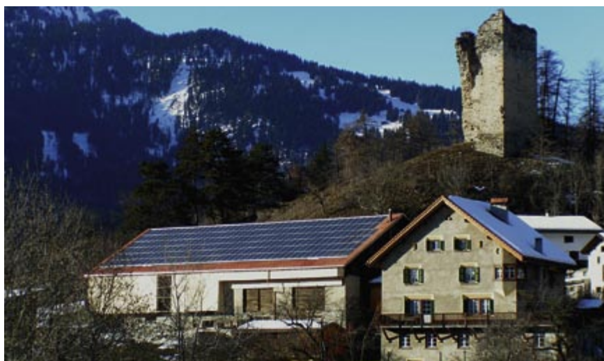
Fig. 1: Installation intégrée dans la toiture.
