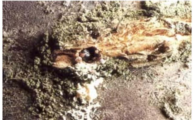
Frische Einbohrstelle des Holzbohrers mit Weissm Bohrmehl. (Foto U. Remund)
