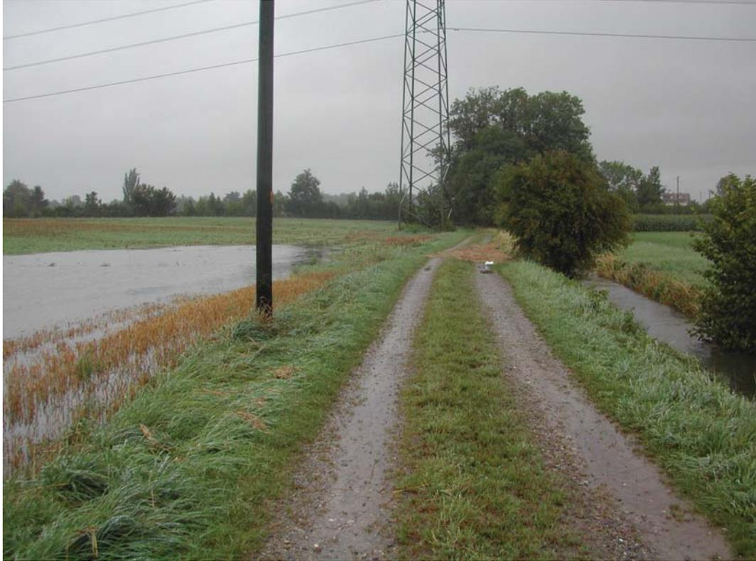
**Abbildung 2.2:** Der Fahrweg bildet eine topographische Barriere, die verhindert, dass Oberflächenabfluss vom Feld links in den Bach auf der rechten Seite der Strasse fließen kann.
