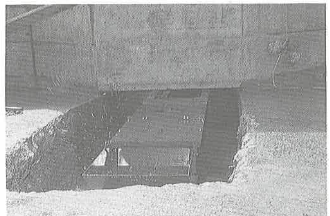
Abb. 3: Mistaustritt-Öffnung aus der Druckkammer nach oben.
