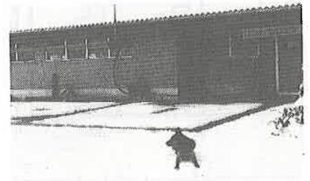
Abb. 16: Betongrube als Fermenter; der Schnee ist im Bereich der Wände getaut, da hier Wärmebrücken vorhanden sind.
