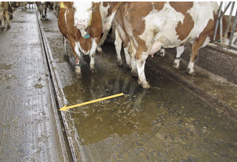
Figure 1 | Pour réduire les émissions d'ammoniac, il est indispensable que l'urine soit rapidement évacuée. (Photo: ART)
