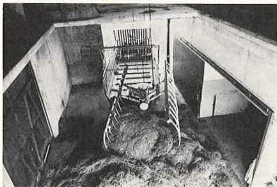
Abb. 1: Mit dem Greifer müssen gepresste Pakete des Ladewagens gut gelockert werden, um ein einwandfreies Belüftungsheu erzeugen zu können. Es stellt sich die Frage, ob drei bis vier Schneidmesser am Ladewagen bei der Greiferbeschickung nicht bereits eine obere Grenze darstellen.
