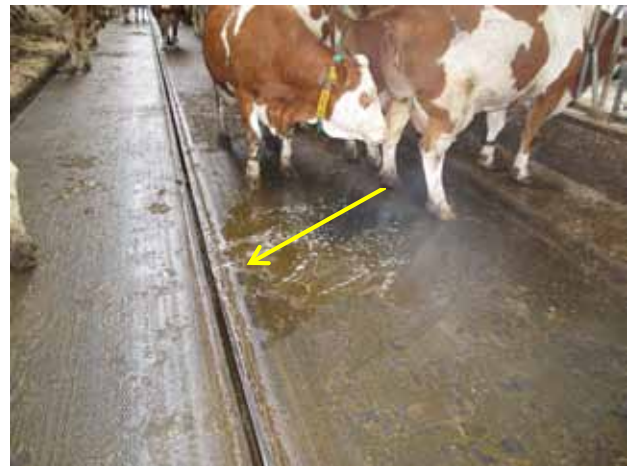
Abbildung 3: Stehende Nässe auf planbefestigter Lauffläche ohne Gefälle (links); rasches Abfließen von Harn durch Quergefälle (rechts).
