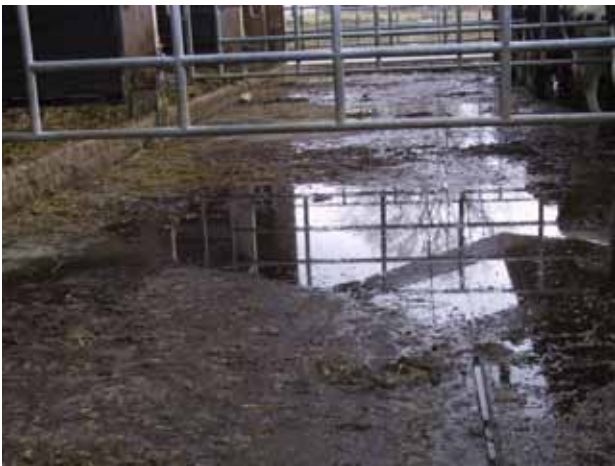
Abbildung 3: Stehende Nässe auf planbefestigter Lauffläche ohne Gefälle (links); rasches Abfließen von Harn durch Quergefälle (rechts).
