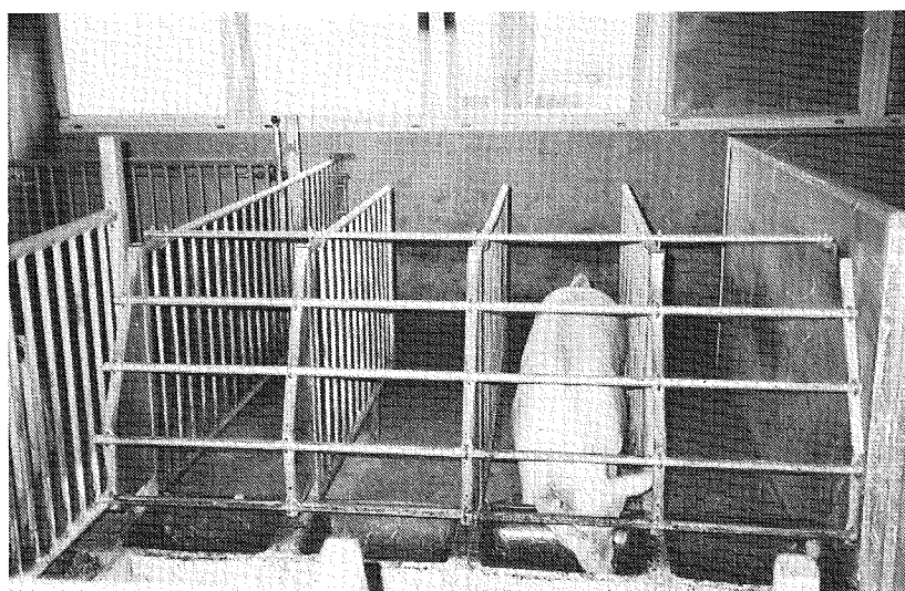
Fig. 3: Vue dans une logette terminée. A l'avant, les emplacements d'affouragement individuel; à l'arrière, le couloir à excréments. A droite, une paroi de l'emplacement de repos est visible. A gauche, la logette du verrat.
