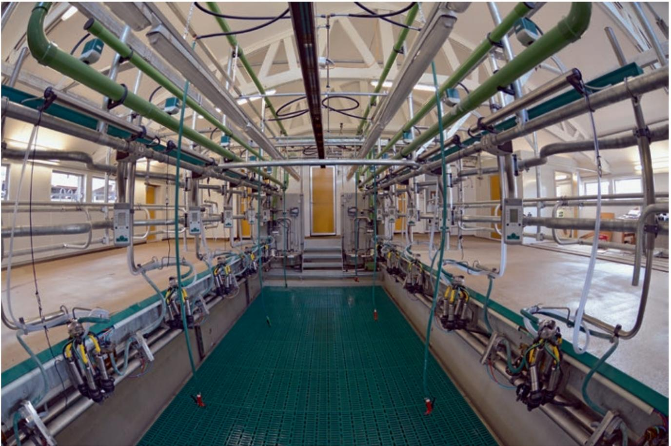
Abb. 6: Beispiel eines Hubbodens in einem Melkstand.
