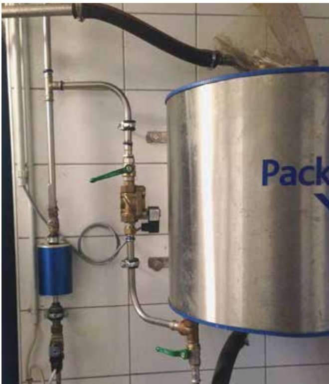
Figure 5 : Refroidisseur tubulaire muni d'une électrovanne (à dr.), refroidisseur tubulaire sans le cache de protection (à g., source : www.jlc-d.fr )
