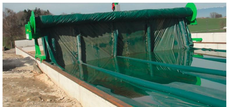
Abb. 4. Das Wasser beschwert die Abdeckplane zusätzlich. Nur im Winter bei Frostgefahr kann dies ein Problem sein.
