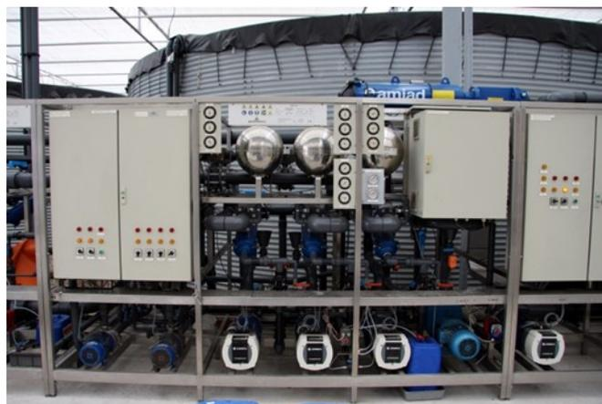
Figure 7. Système de désinfection de l'eau aux UV. (Photo : V. Günther)
