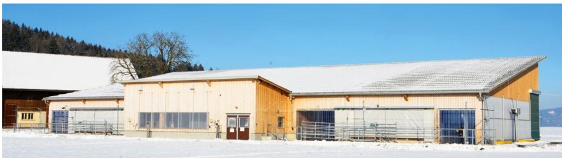
**Bild 4:** In einem Stall werden die unterschiedlichen Bedürfnisse an die Temperatur am besten mit einem wärmegeprägten Melkbereich und einem nicht wärmegeprägten Liege- und Fressbereich umgesetzt.
