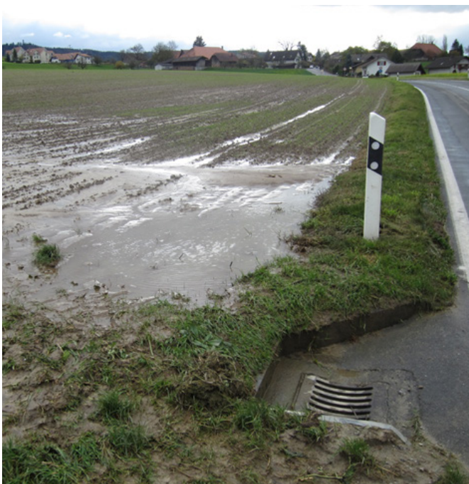
Abbildung 4 | Oberflächenabfluss aus einem Acker direkt in einen Strasseneinlaufschacht führt zu Einträgen von Nährstoffen und anderen landwirtschaftlichen Hilfsstoffen in Oberflächengewässer (Foto: Volker Prasuhn, Agroscope).
