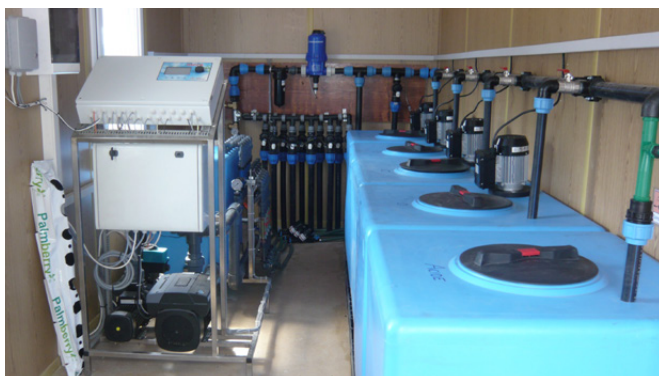
Figure 5. Automate pour la préparation de la solution nutritive adaptée pour les cultures de baies sur substrat (photo: Agroscope).
