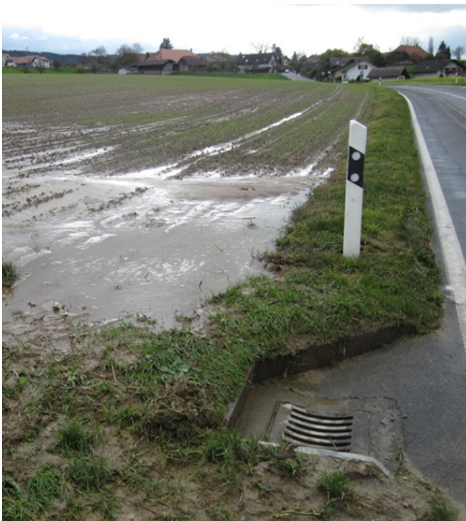
Figure 4. Ecoulement des eaux de surface provenant d'un champ en amont immédiatement dans une grille collectant les eaux de la route: une voie directe pour la contamination des eaux de surface par des éléments nutritifs ou des matières auxiliaires de l'agriculture (photo: Volker Prasuhn, Agroscope).
