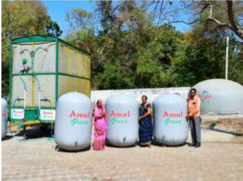
*Modèle de biogaz flexible pour la sécurité énergétique et l'action climatique (Inde)*
