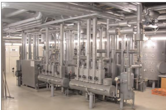
Dampfverteilung und Kondensatrückführung.
