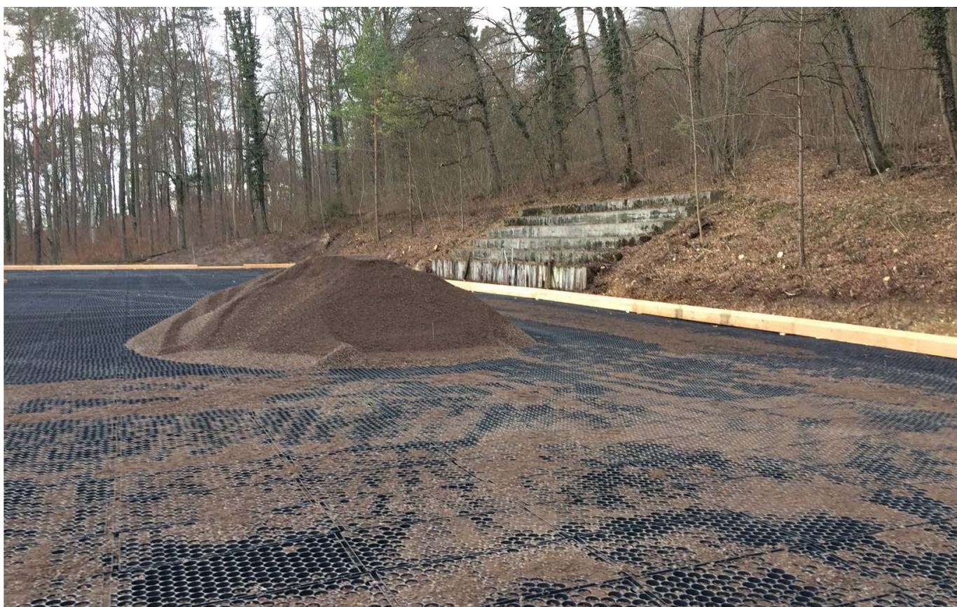
Abbildung 12: Rasterplatten, Gummimatten oder Kunststoffverbundsteine eignen sich gut als Trennschichtmaterial. Sie können einfach verlegt und anschließend verfüllt werden (Quelle: Agroscope SNG; Quelle letztes Bild: Bruggmann Reitplatzbau).
