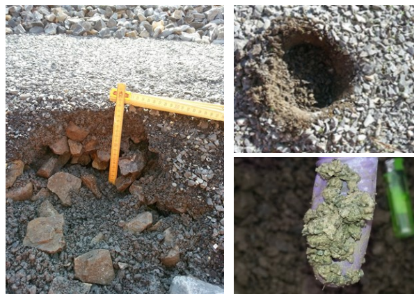
Figure 4: Substrat typique utilisé sur les chemins d'accès aux abords des voies.
