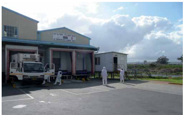
Abattoir de porcs – livraison et bassin de nettoyage l'un à côté de l'autre!
